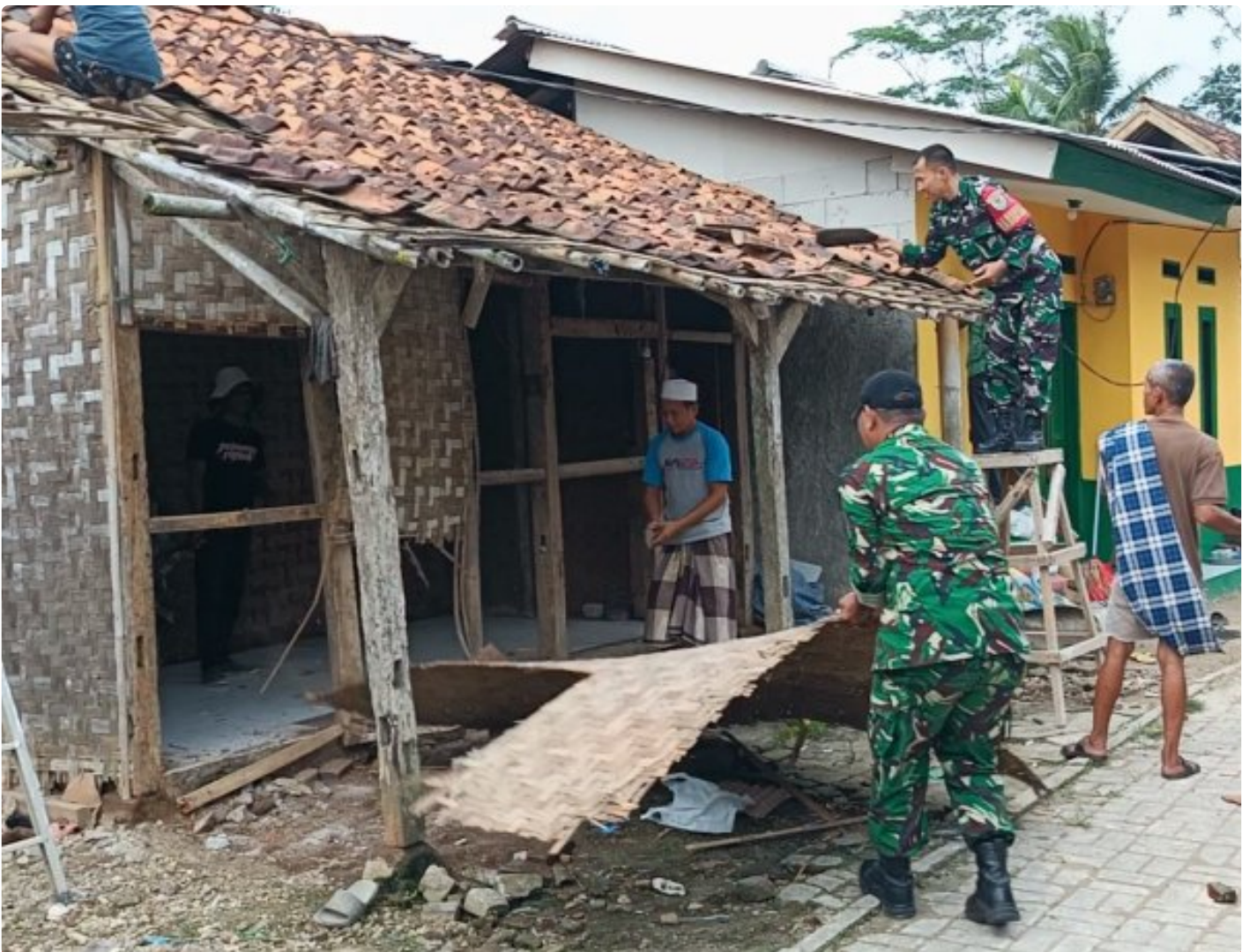
Pembongkaran Rumah Bapak Narmin
